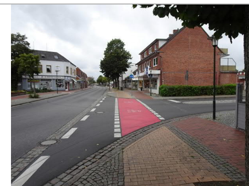
Am KP B 199/Kirchhofstraße entstehen durch die einseitige Führung des Radverkehrs Konflikte
