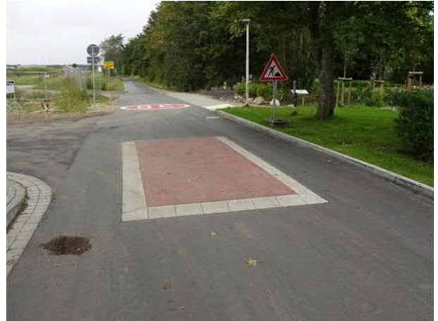
Verkehrsberuhigung durch Berliner Kissen und Fahrbahnmarkierung (Mühlenberg)
