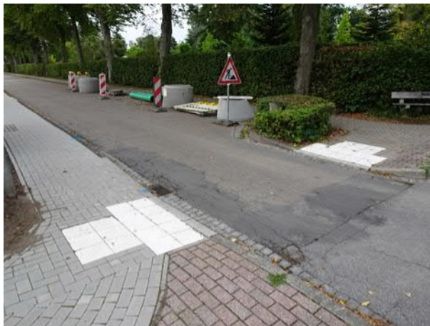
Einsatz von taktilen Elementen an Querungsstellen (Propst-Nissen-Weg)
