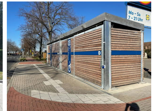
Abschließbare Sammelgaragen an einer ÖV-Schnittstelle (Pattensen)
