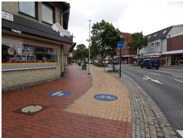
Getrennter Geh- und Radweg (Zweirichtungsradweg) an der Hauptstraße (B 199)
