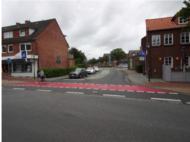
Sichteinschränkung durch Einbauten (KP B 199/Kirchhofstraße)
